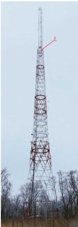
Рис. 4. Башня высотой 200 м в г. Самара. Период основного тона собственных колебаний башни составил 3,6 с, декремент колебаний 0,0141–0,0112
