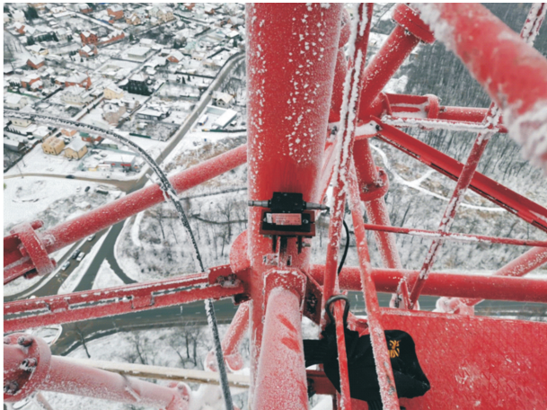
Рис. 5. Датчик, закрепленный на поясе башни в процессе измерения на отметке +140,0 м
