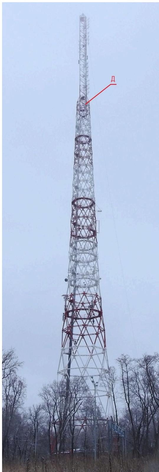
Рисунок 4. Башня высотой 200 м в г. Самара. Период основного тона собственных колебаний башни составил 3.6 с, декремент колебаний 0.0141-0.0112.
